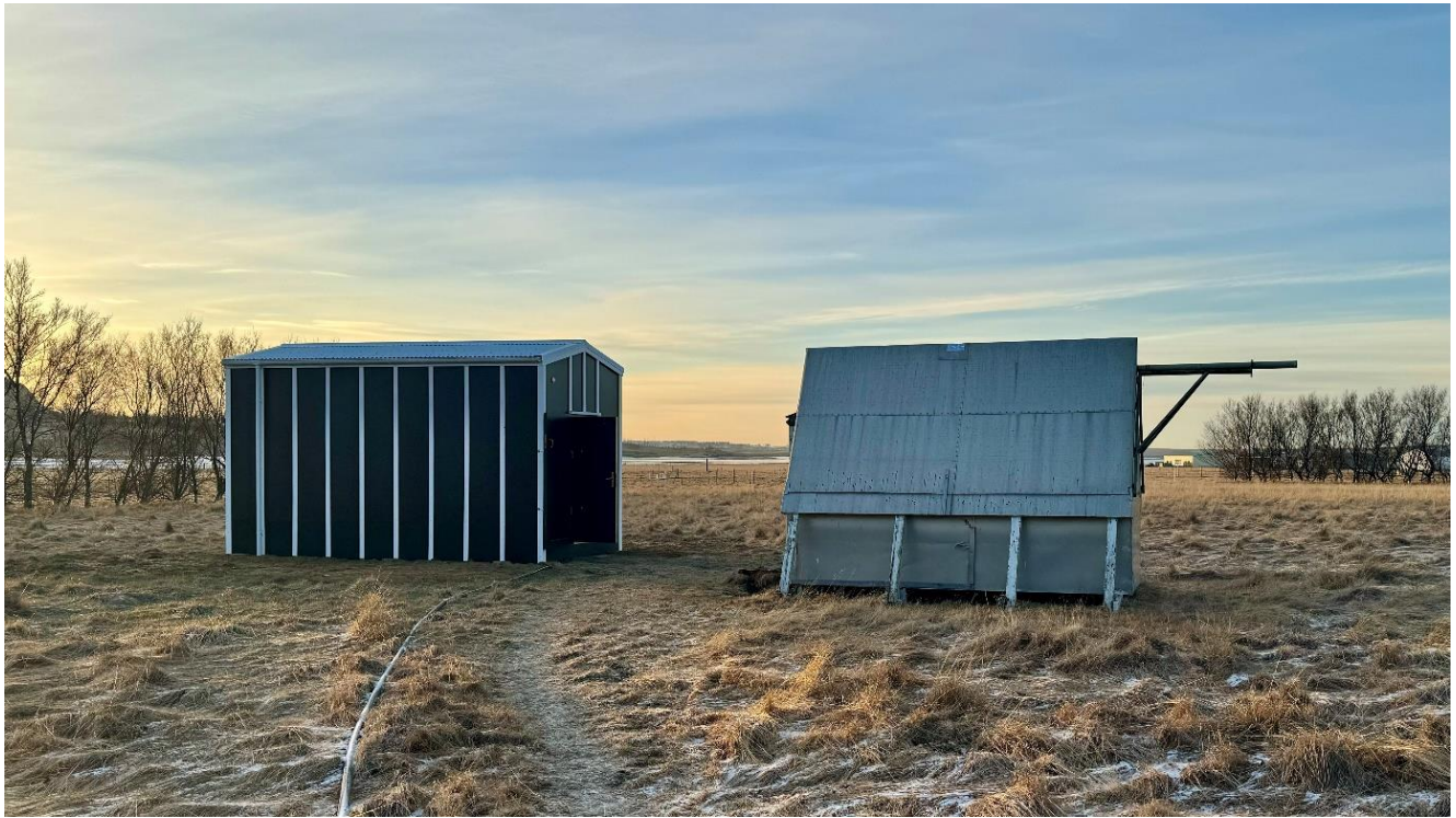
Mynd 13 Nýja húsið við Segulmælingarstöðina í Leirvogi (vinstri) og gamla húsið (hægri) sem hefur þjónað starfseminni vel áratugum saman.
